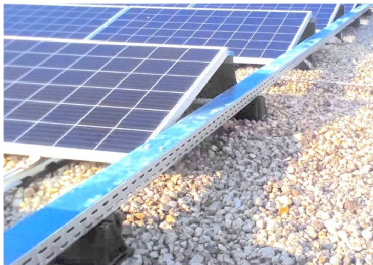
Rys. Przykład wykonanej trasy kablowej DC
